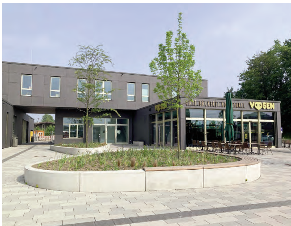
Die neue Mobilstation am Bahnhof Rommerskirchen
