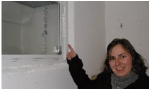
Schwachstellen wie Kellerfenster sollten gesichert werden!
